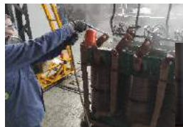
Limpieza y secado de parte activa
